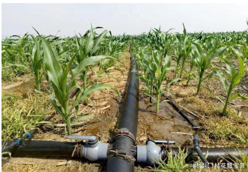
图 4 玉米田滴灌管道铺设
